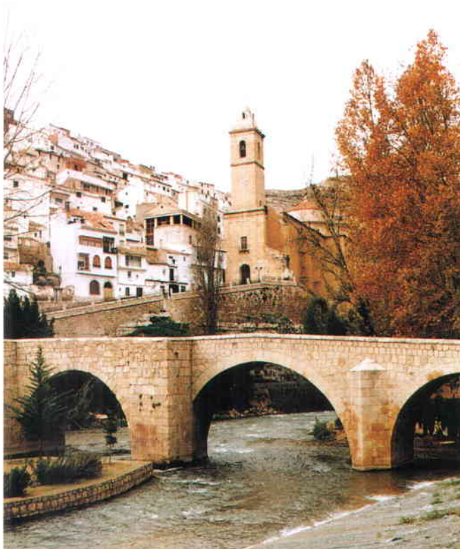
Alumnos de la Escuela Taller han empedrado el Puente Romano y la calle que da acceso a la iglesia.
